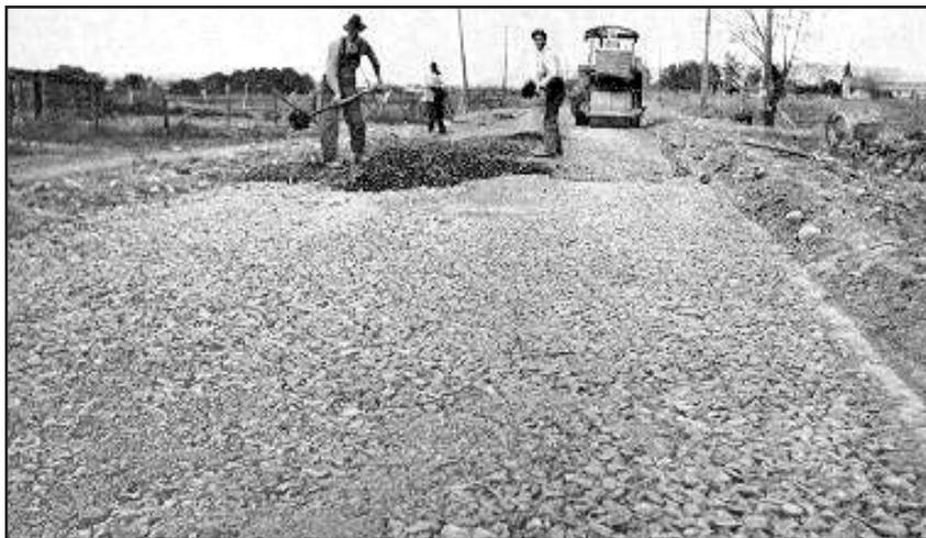
Fig.43 – a) Sezione massicciata in Macadam all'acqua; b) Operai all'opera.
